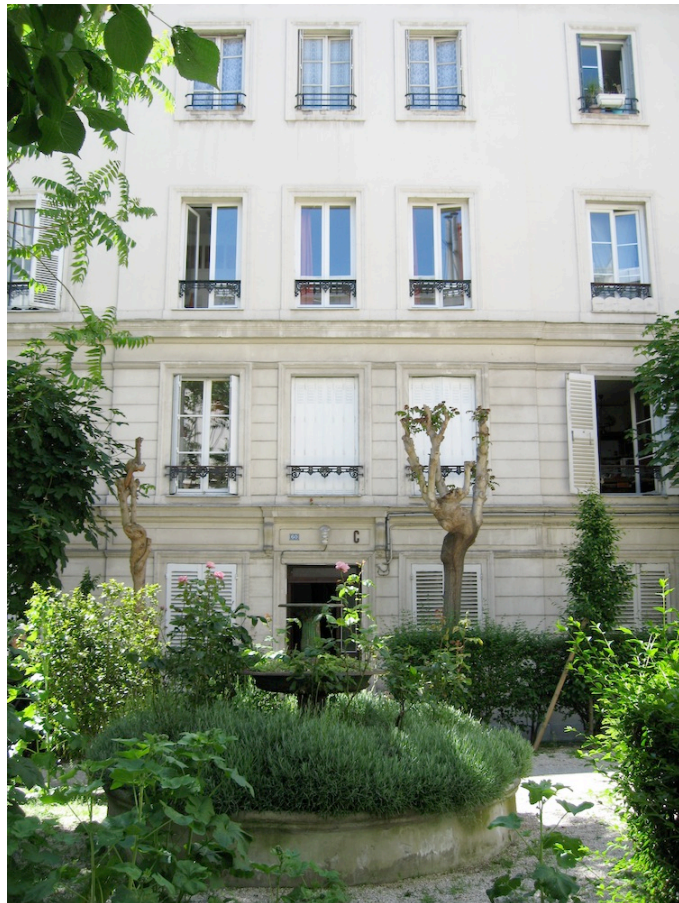
III. 6 – Cité Rochechouart. Cour intérieure. Photographie F. Chevallier
