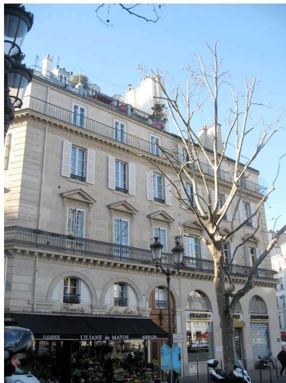
III. 36 - Immeuble place Franz Liszt. Photographie F. Chevallier.
