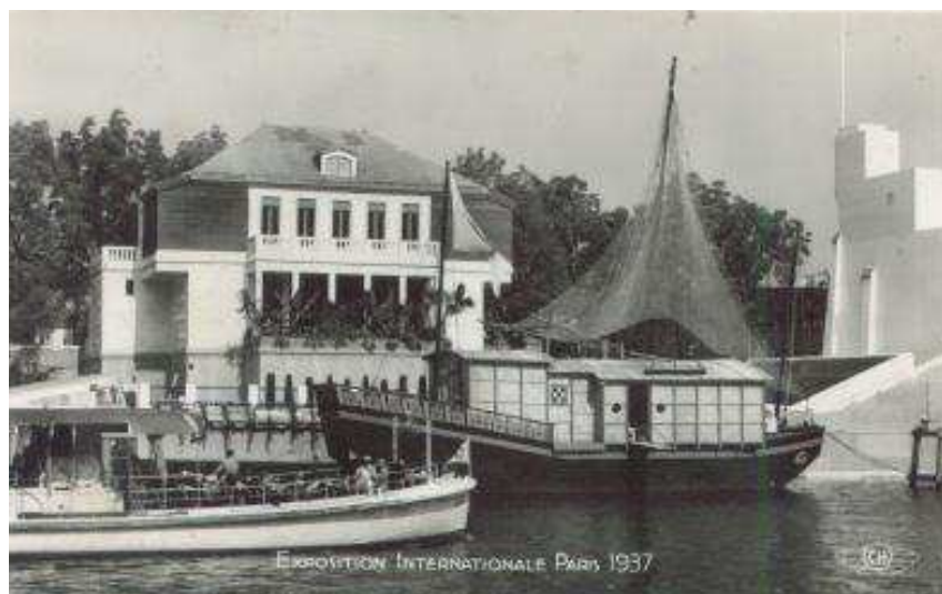
Figure 20 - Pavillon de la Réunion (Source : Archive Dervaux)
