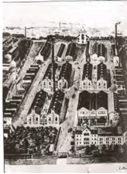
Figure 13 L'usine de Saint-Denis
