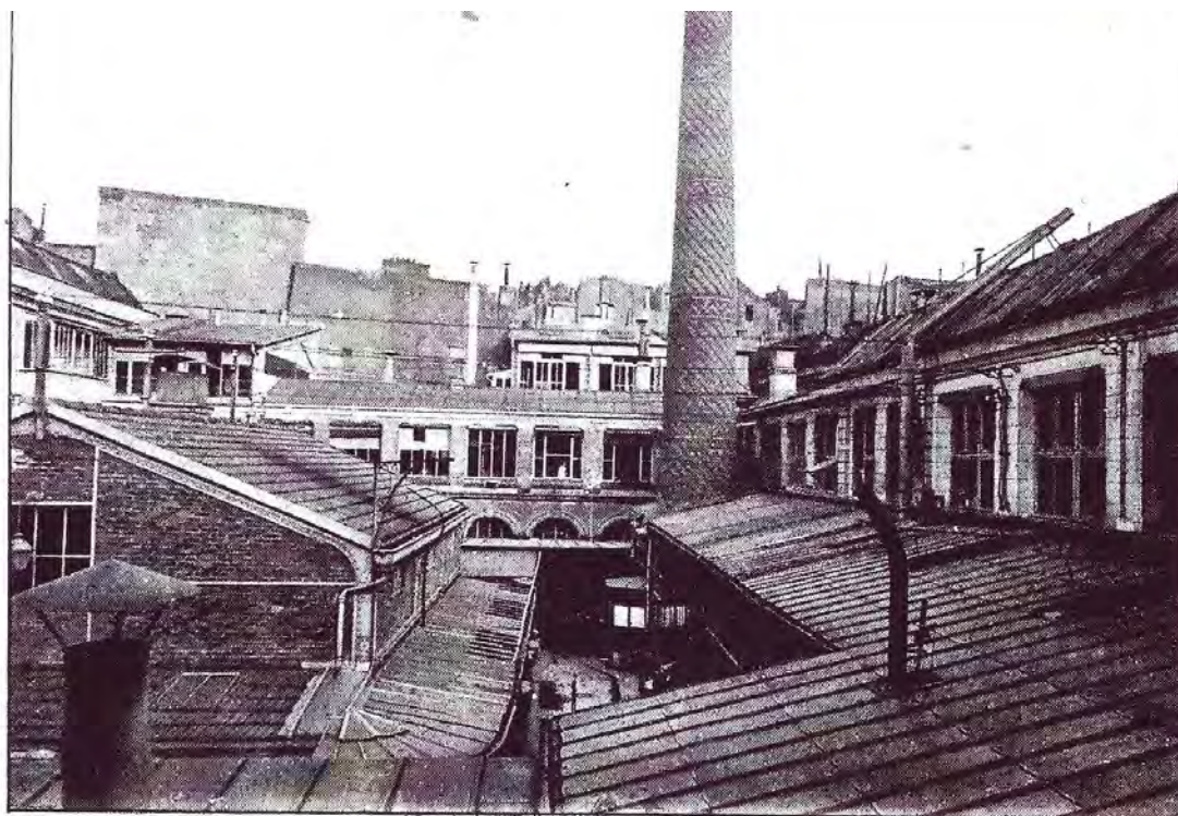
MAISON DE PARIS — VUE A VOL D'OISEAU DES LABORATOIRES ET ATELIERS DE FABRICATION
