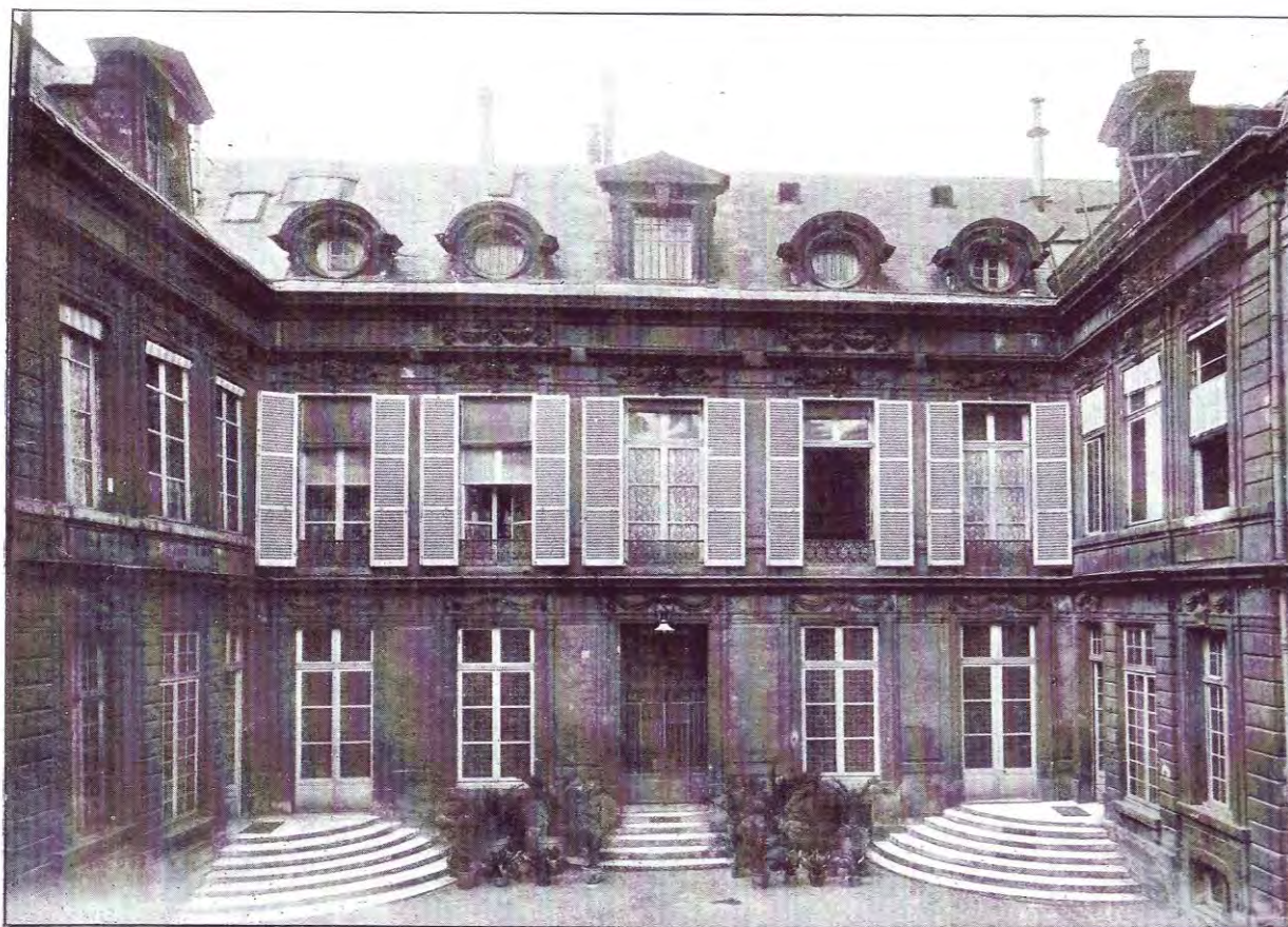
HÔTEL D'AUMONT. — COUR D'HONNEUR : FAÇADE DE FRANÇOIS MANSART.
