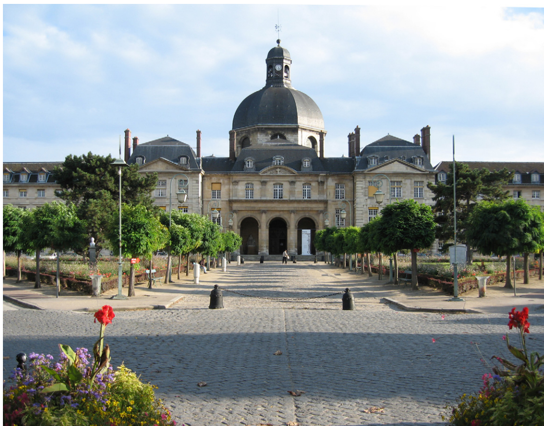
Fig. 1 – The Salpêtrière hospital.
