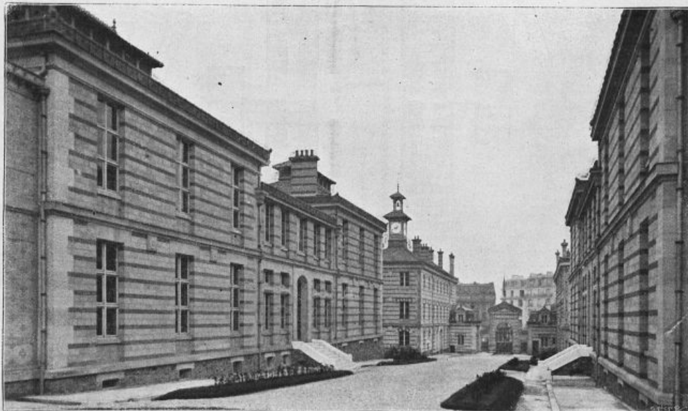
Figure 5. — Vue de la cour d'honneur, des pavillons de médecine et de chirurgie, des bâtiments des services généraux, de la porte d'entrée et du bâtiment de l'administration.
