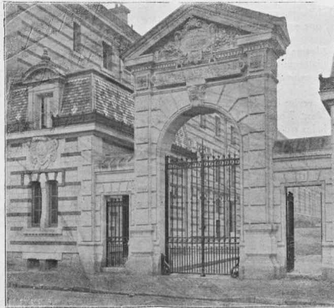
Figure 4. — Porte d'entrée principale, rue Carpeaux.
