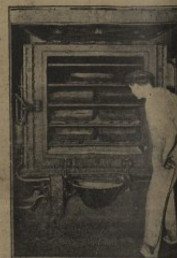
Armoire à vide pour dessécher les intraits dans le vide à basse température
