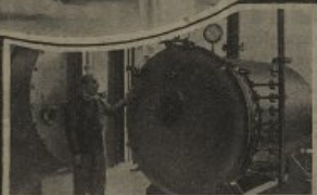
l'étuve de magasinage sous vide très profond
