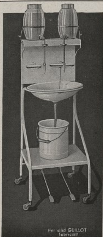
L. 400 Lavabo roulant à deux barils actionnés par pédales.
