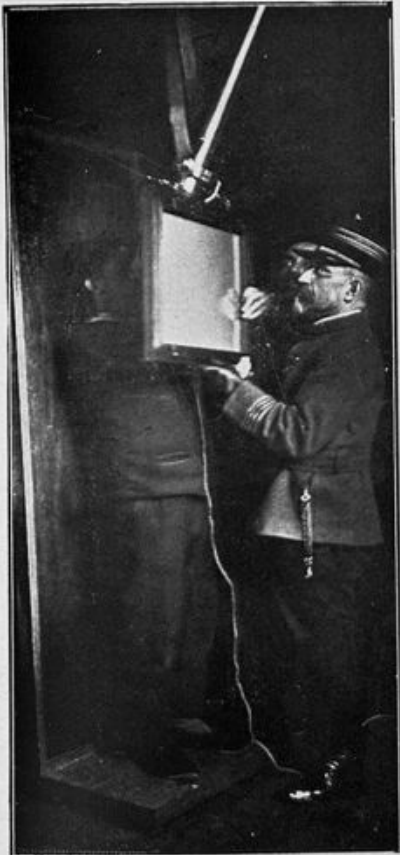
Écran fluorescent disposé pour suivre les mouvements, sous l'électro-aimant, d'un projectile logé dans la langue.
