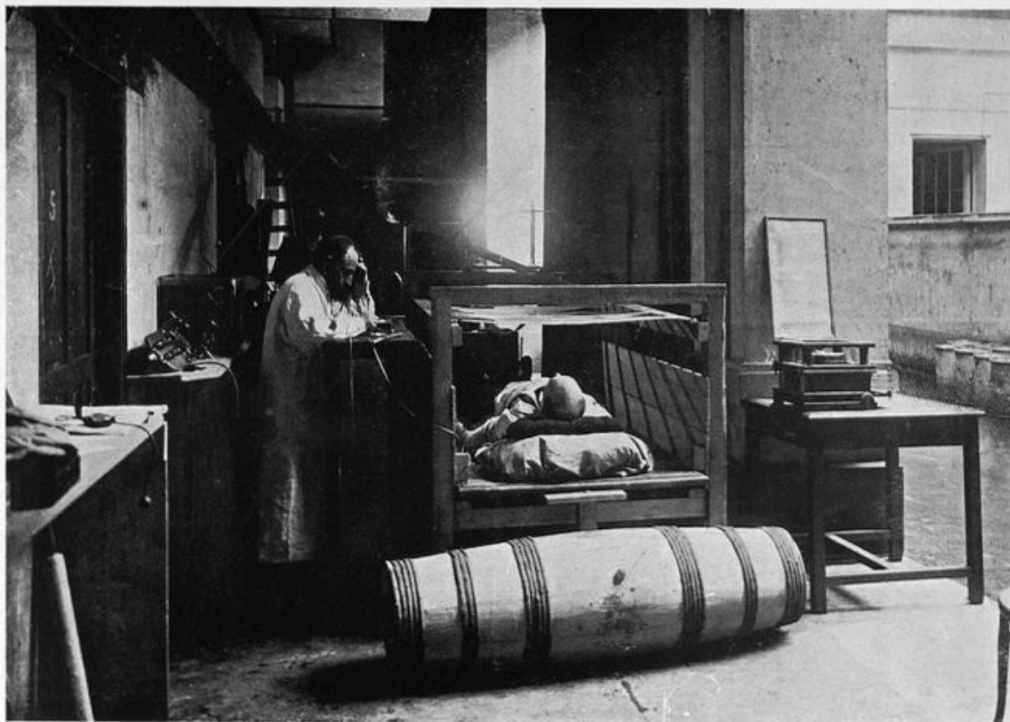
La cage d'application. L'ondemètre et le baril rempli d'eau physiologique par lequel on remplaçait le patient dans les mesures.
