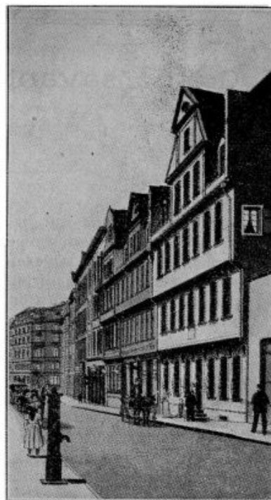
Maison natale de Goethe à Francfort.
