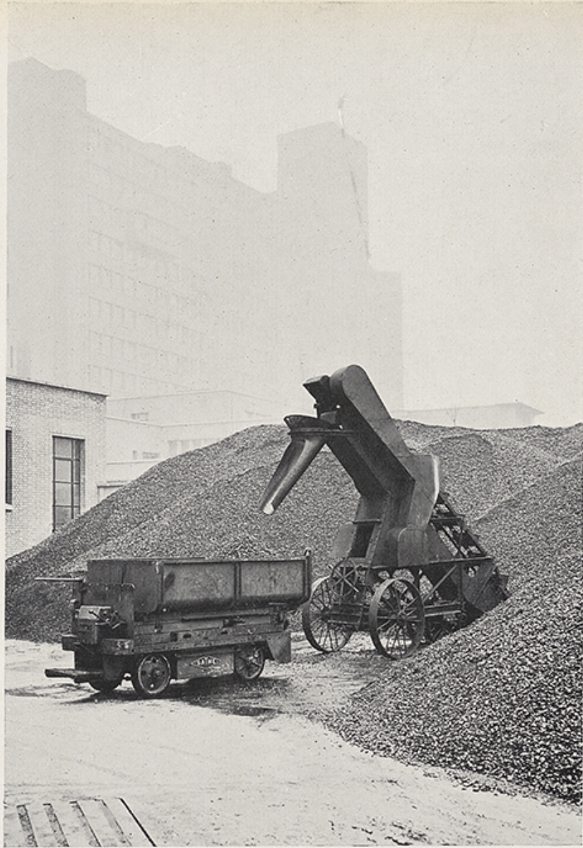
PARC A CHARBON DE L'USINE
