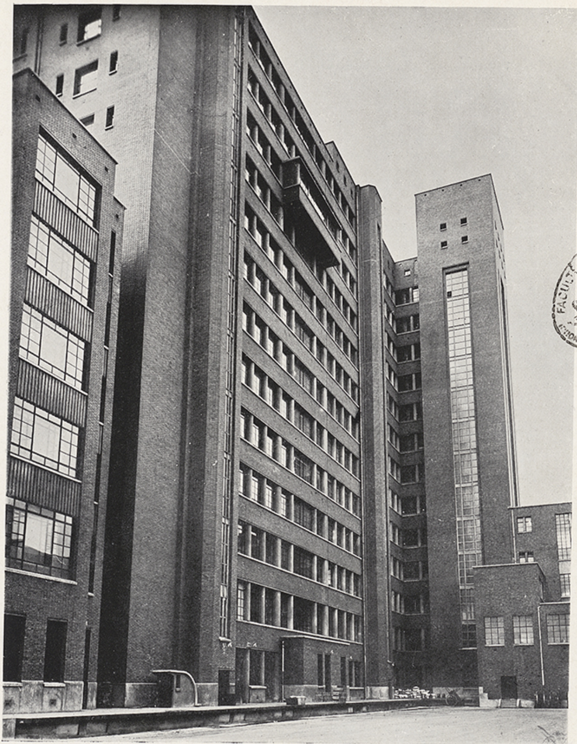
LE BLOC DES ASCENSEURS
