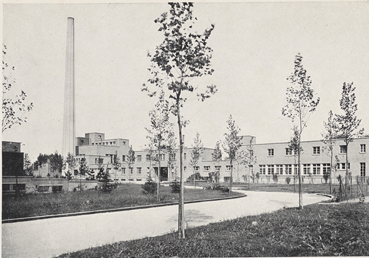
VUE GÉNÉRALE DE L'USINE
