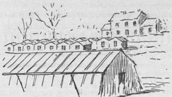
Fig. 87. — Baraques Collet et Bessonneau établies à proximité d'une petite gare d'évacuation. La baraque Bessonneau occupe le premier plan, les baraques Collet, accouplées, sont au second plan.
