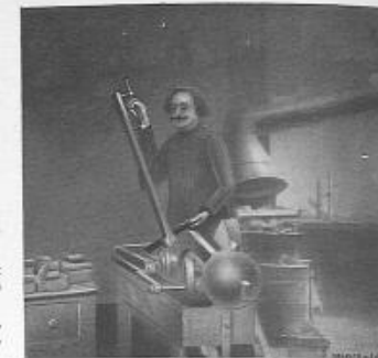
Fig. 253. Collection Drapier et fils. Ouvrier coupant un ressort à la cisaille.
