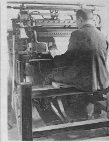
Fig. 288 Ouvrier tissant un bas élastique sur le métier.
