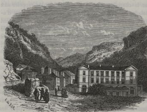
Entrée des Eaux-Chaudes.
