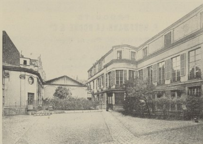
Vue générale des Bureaux
