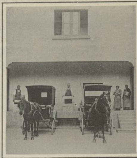
Quai de Chargement
