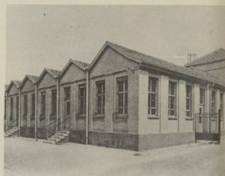
Vue générale des Laboratoires de recherches
