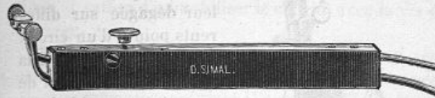
Fig. 22. — Manche galvano-caustique simple.
