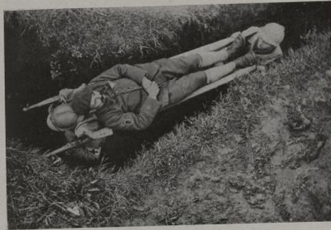
Fig. 13. — Brancard réglementaire butant au niveau d'un coude dans un boyau. Les brancardiers s'efforcent de franchir l'obstacle en soulevant le brancard dont ils ont rapproché les hampes en détendant les compas. Le blessé est coincé entre les hampes et gêné par l'angle des compas.
