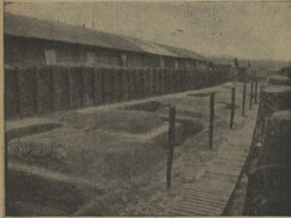
LES TRANCHÉES ET LES PARE-ÉCLATS AUTOUR DE NOS BARAQUES
