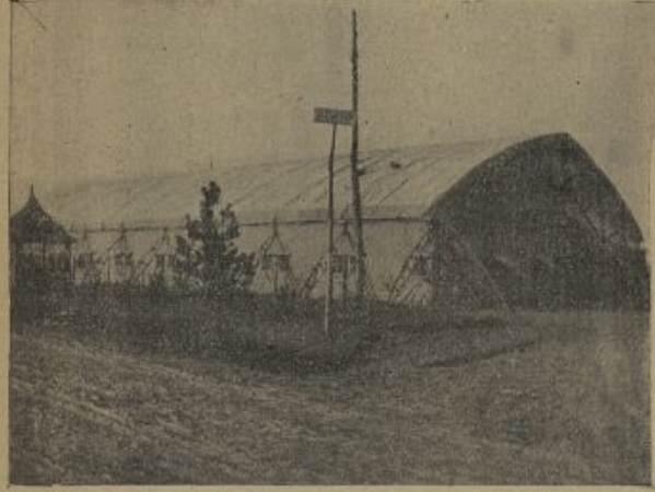
LE HANGAR TERMINÉ A UN ASPECT IMPOSANT.
