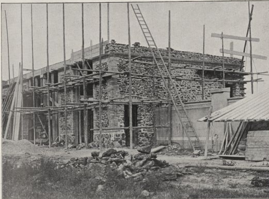
NOUVEAUX AGRANDISSEMENTS DE L'USINE DE LA CARNINE LEFRANCQ à ROMAINVILLE L'exigüité de notre format ne nous permet pas de donner une idée exacte de l'importance des travaux.
