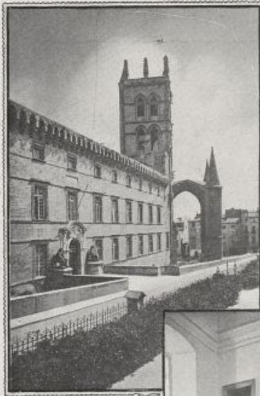
FAÇADE DE LA FACULTÉ
