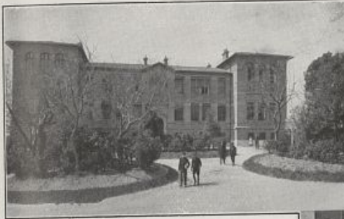
VUE GÉNÉRALE DE L'ÉCOLE DU SERVICE DE SANTÉ COLONIAL.
