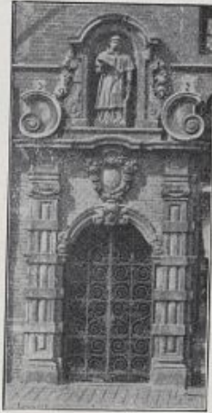
PORTAIL DE L'ANCIEN HOSPICE SAINT-LAURENT à Gand (1564)
