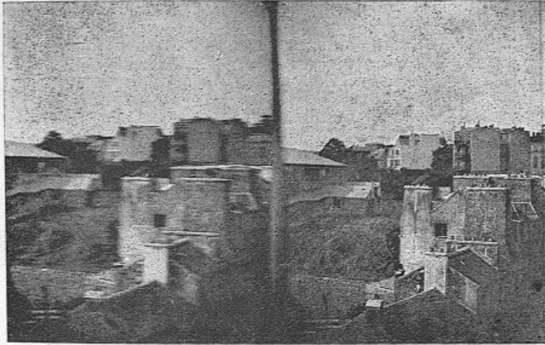
Fig. 89. — Deux images successives obtenues sur la bande pelliculaire : l'image de gauche sans arrêt de la bande au moment de l'admission de la lumière ; celle de droite avec arrêt de la bande.
