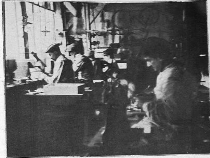
Ateliers BRUNEAU Banc de polissage et bains de nickelage.
