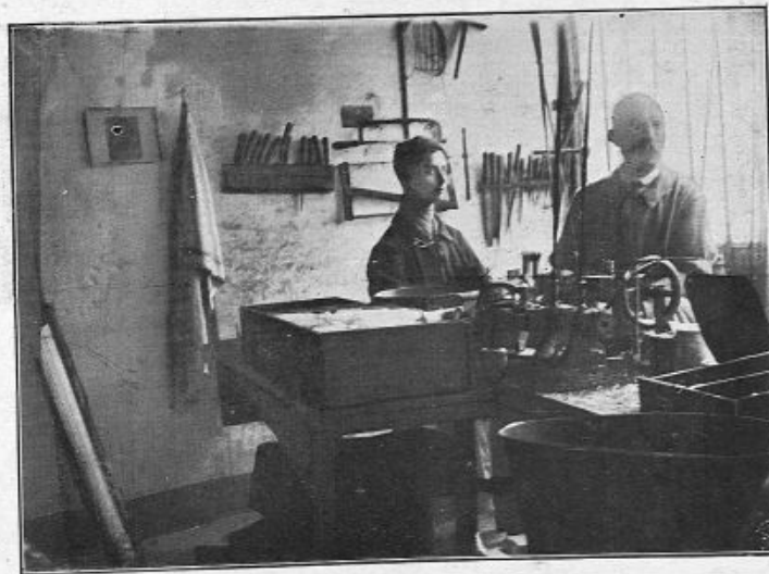
Ateliers BRUNEAU Atelier de rodage des verres de seringues "Record".
