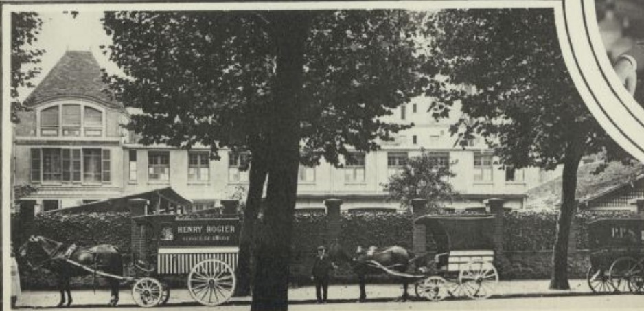
Vue Générale de l'Usine
