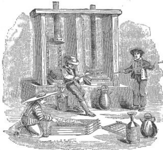
FIG. 22. — Presse à écrou pour expression de l'huile.
