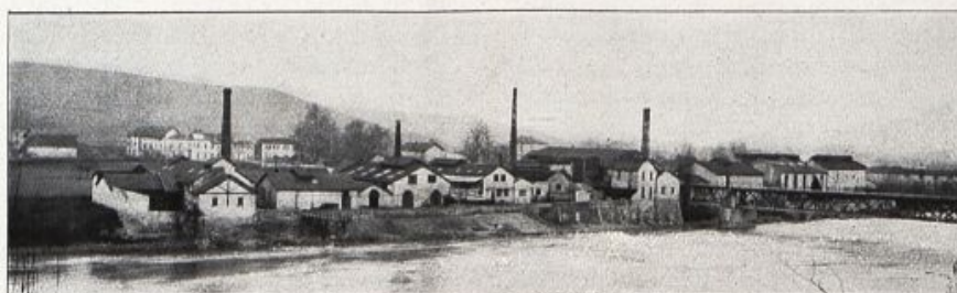
Société Chimique des Usines du Rhône. — Usine de La Plaine (Vue générale)
