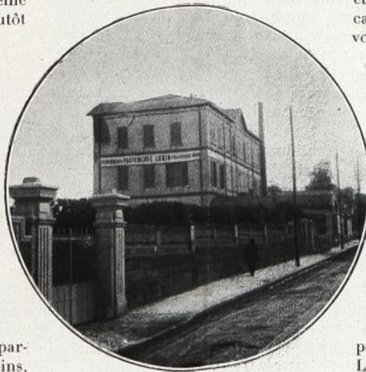
Usine Lubin à Cannes
