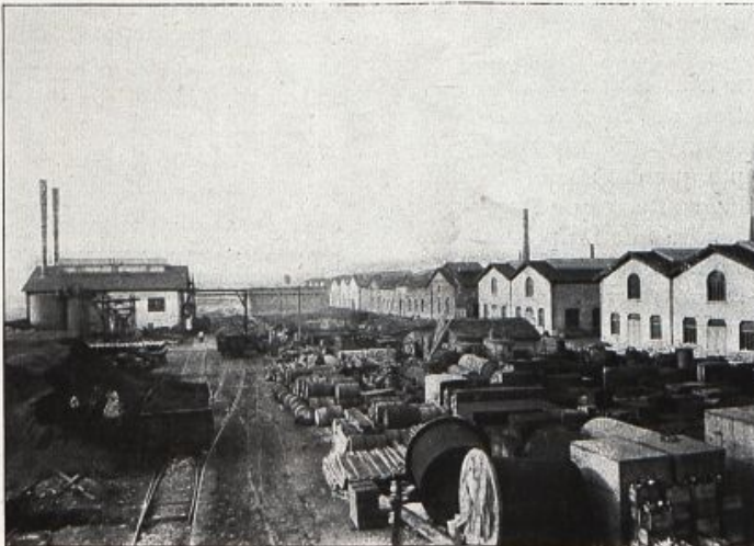
Société Chimique des Usines du Rhône (3 e usine en construction)
