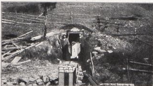
Vue d'une galerie de mine
