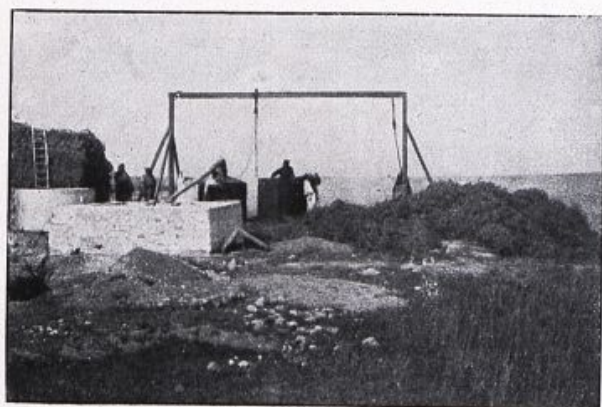
VUE D'ENSEMBLE D'UNE DISTILLERIE TUNISIENNE
