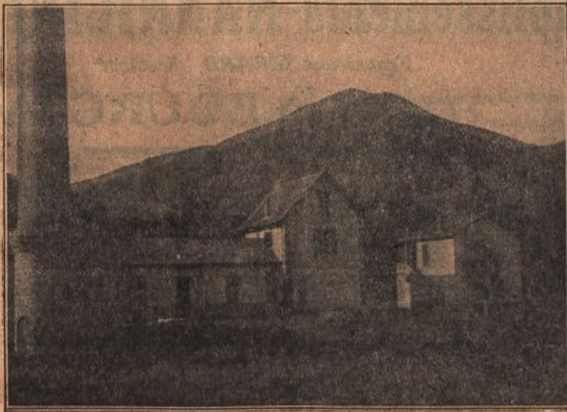
Ex-Usine Schimmel, actuellement à MM. Gattefossé & Fils.
