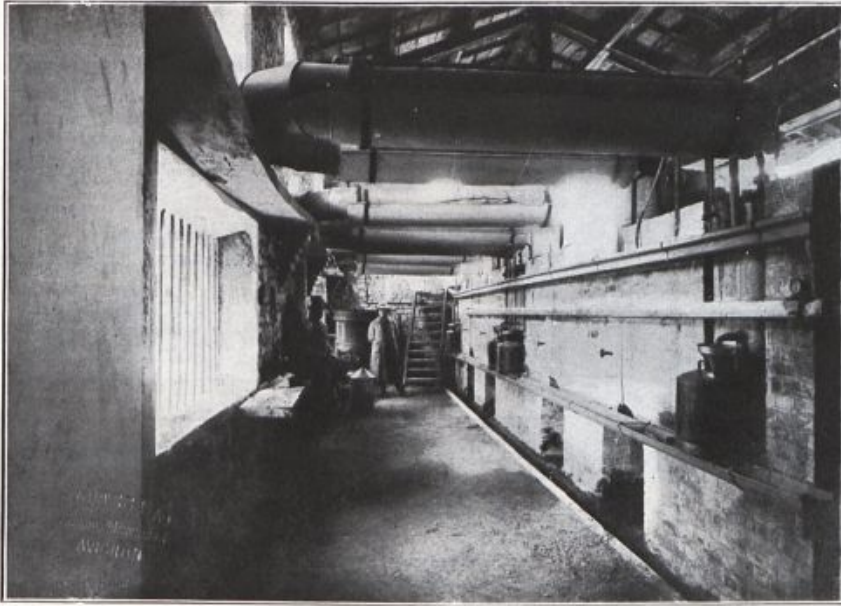
Les Condenseurs aériens à l'Usine de la Lavande française, à Sault.
