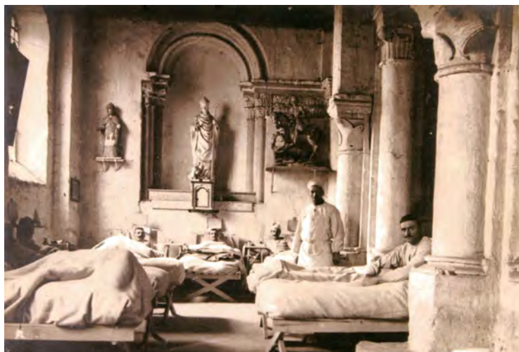
Fig. 3 : L'église de Glennès, près de Craonne (Aisne) transformée en ambulance accueillant des grands blessés. Sa capacité comprenait 150 lits, ainsi que 100 lits supplémentaires sous baraquement réservés aux blessés de passage.
