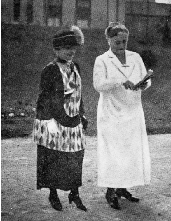
Fig. 9. Marie Louise Lefort (à droite) et Miss Bangs (à gauche) surveillent la construction du nouvel hôpital.
