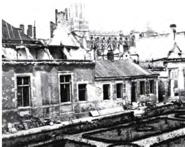
Fig. 3. Le vieil Hôpital Saint Marcoul (ou Hôpital Noël Caqué) détruit par les bombardements. Il sera restauré pour devenir l'Hôpital Provisoire, inauguré le 1 er juin 1919.
