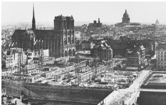
Fig. 14. Le chantier du nouvel Hôtel-Dieu vers 1870.
