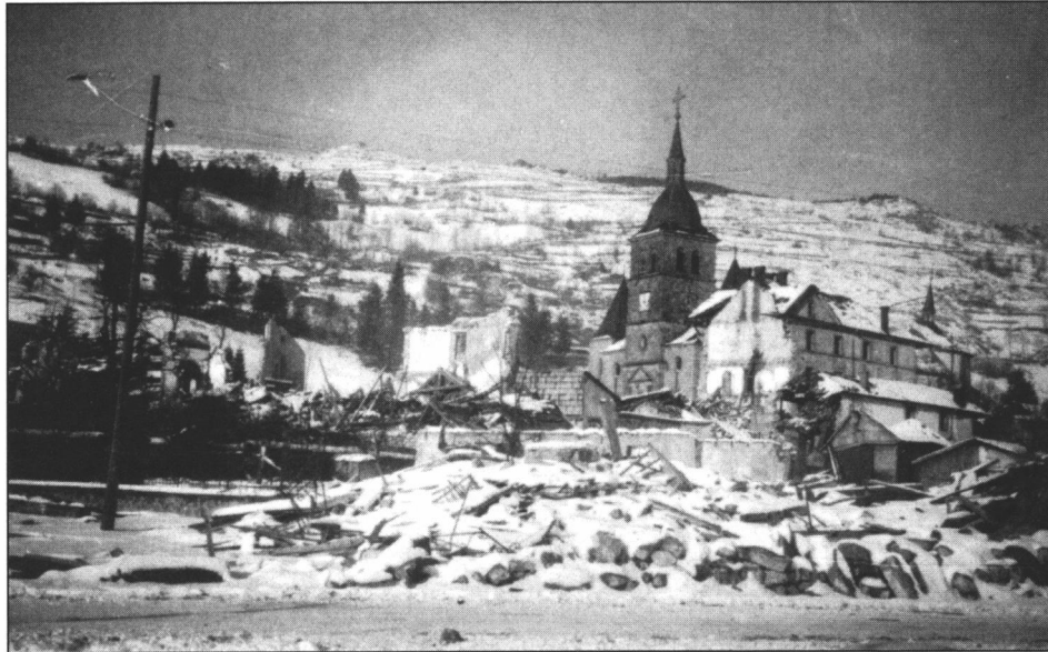
Les maisons de La Bresse, dynamitées par les Allemands avant leur retraite. La ligne de front passait le long de la ligne de crête visible au-dessus du village.
