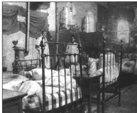
Fig. 7 - Une église transformée en hôpital temporaire - 1915
