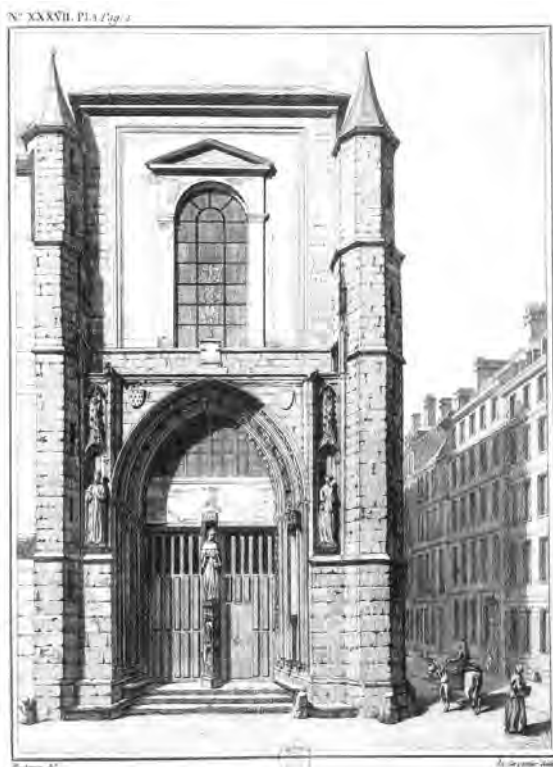
Fig. 1 - Façade de la chapelle Saint-Yves de Paris au XVIII e siècle. (Cliché BNF)
